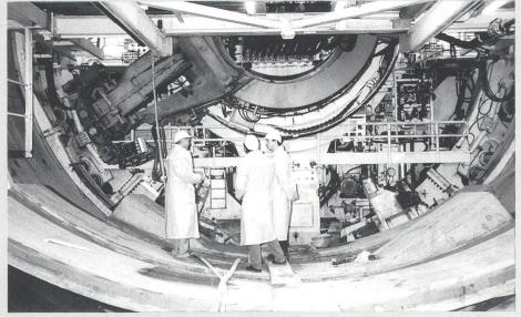
Vortriebsschild der imposanten Tunnelbohrmaschine
