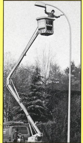
Korrosionsschutz an Stahlkandelabern
