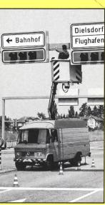
Korrosionsschutz an Signalanlagen
