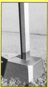
Betonschutz an Mastsockeln
