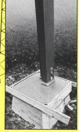
Sanierung von Mastsockeln
