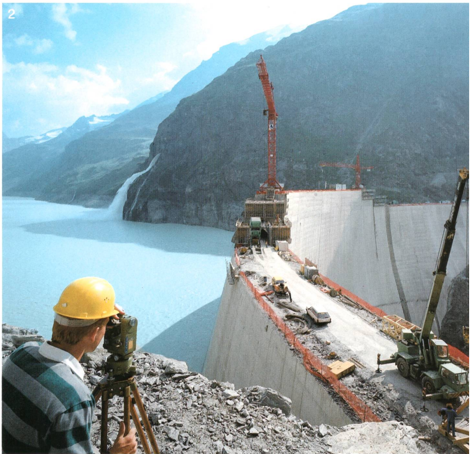
2 Grâce à une surélévation de seulement 13,5 m du barrage voûte de Mauvoisin en Valais, il est possible de déplacer chaque année 30 mio de mètres cubes d'eau de l'été à l'hiver, et de produire ainsi en hiver quelque 100 mio de kWh d'électricité supplémentaires.
