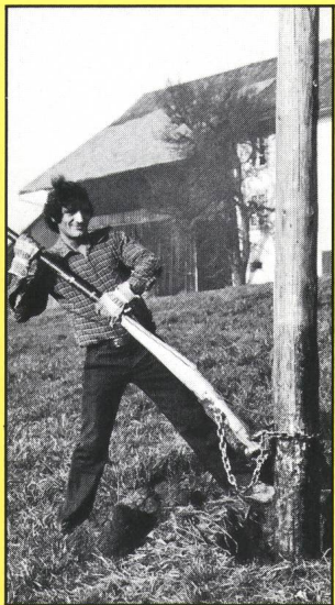
Nachimprägnierung von Holzmasten
