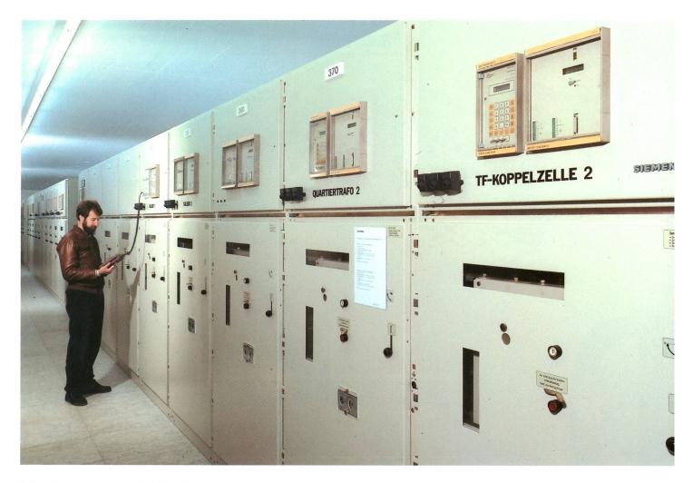
Mittelspannungsschaltanlagen von Siemens
