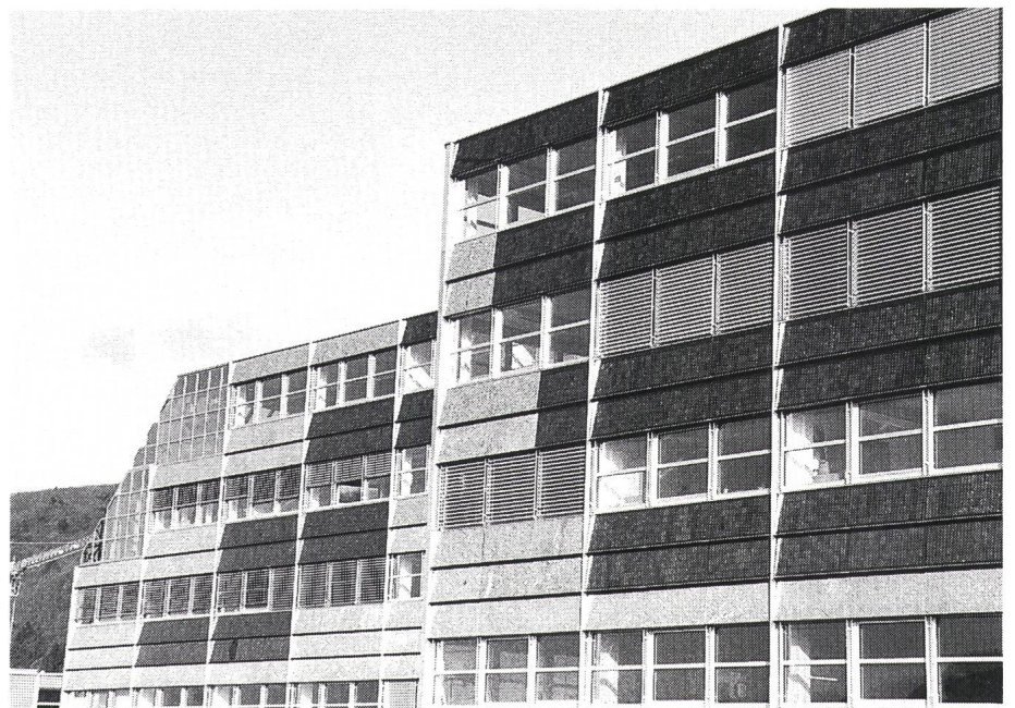
Bild 1 Die Photovoltaik-Grossmodule in der Fassade des Gewerbebaus «Windmühle» in Biel-Bözingen
