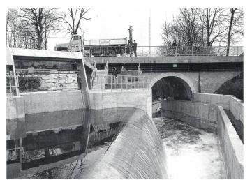
Das Kleinwasserkraftwerk Roggwil, im Kanton Bern, hat eine installierte Leistung von 250 kW. Dies entspricht etwa 10% des maximalen Leistungsbedarfs der Gemeinde Roggwil
