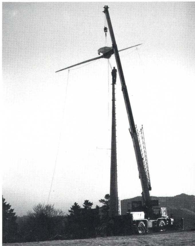
Bild 2 Montage der neuen Gondel auf den bestehenden Mast der Installation auf dem Sool
