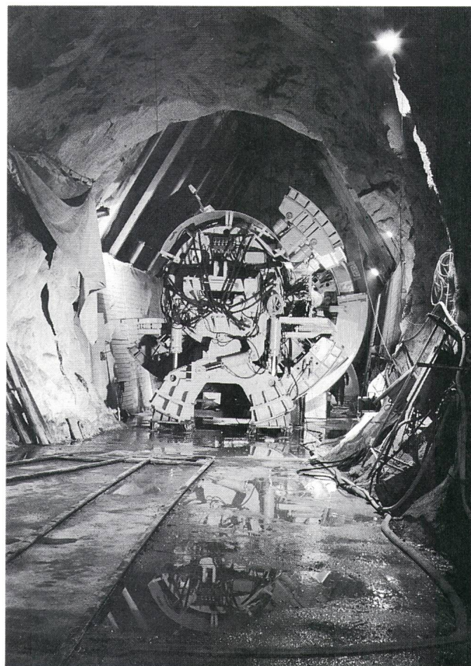
Bild 4 Stollenfräse beim Einsatz für den Druckstollen Pradella Martina
