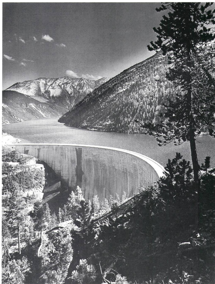
Bild 1 Die doppelt gekrümmte Bogenstaumauer Punt dal Gall des Livignosees
