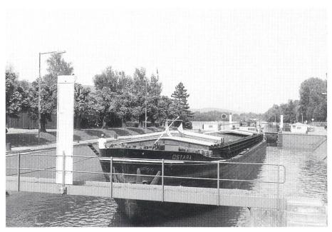
Bild 4 Schiffahrtsschleuse mit 45° geneigten Trogwänden
