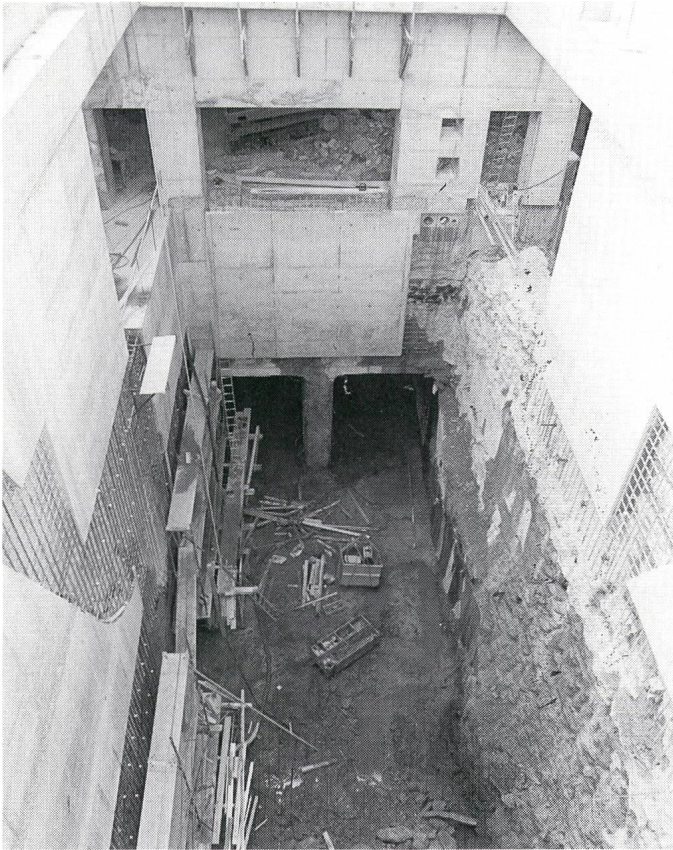
Bild 3 Um Platz für die neuen Maschinen zu schaffen, muss in jeder Maschinengrube zuerst der alte Beton, nachher Fels ausgebrochen werden. Gleichzeitig werden die Trennwände von oben nach unten abgespitzt, an der Oberfläche neu aufbetoniert und unterfangen
