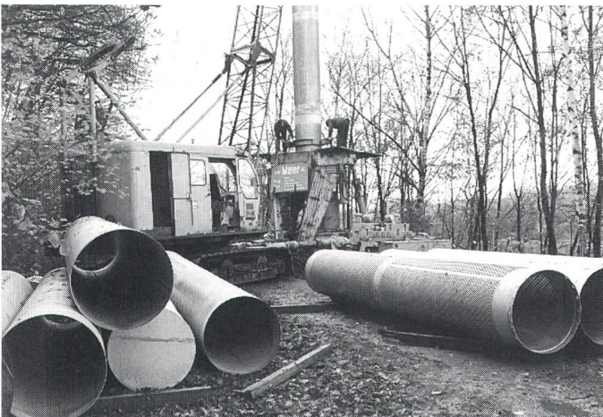
Bild 15 Ein Filterrohr wird in das Bohrloch eines Uferinfiltratbrunnens abgesenkt. Das gewonnene Grundwasser wird für die Kühlung der Generatoren und Transformatoren verwendet und nachträglich einer Wärmepumpe zur Gebäudeheizung zugeführt
