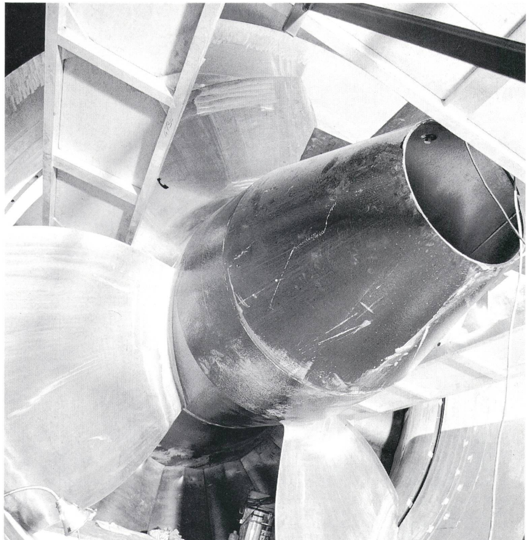
Bild 12 Den Abschluss der Turbinenmontage bildet der Einbau der Aussenkranzdichtungen von der Saugrohrinnenseite der Maschine her
