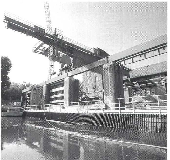
Bild 17 Der neue Rechen, welcher das Geschwemmsel am Eintritt in den Turbineneinlauf hindert, ist bei den landseitigen Maschinen bereits montiert. Später wird er noch mit einer Geschwemmselrinne und zwei Rechenreinigungsmaschinen ausgerüstet werden
