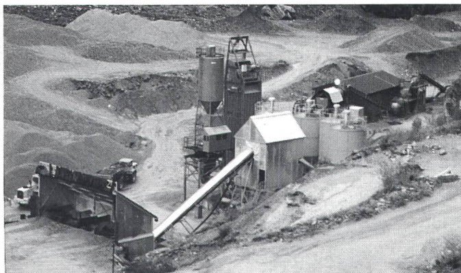
Pour la surélévation du barrage de Mauvoisin quelque 70000 m 3 de béton, préparés sur place, ont été coulés
