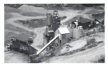
Pour la surélévation du barrage de Mauvoisin quelque 70 000 m³ de béton, préparés sur place, ont été coulés
