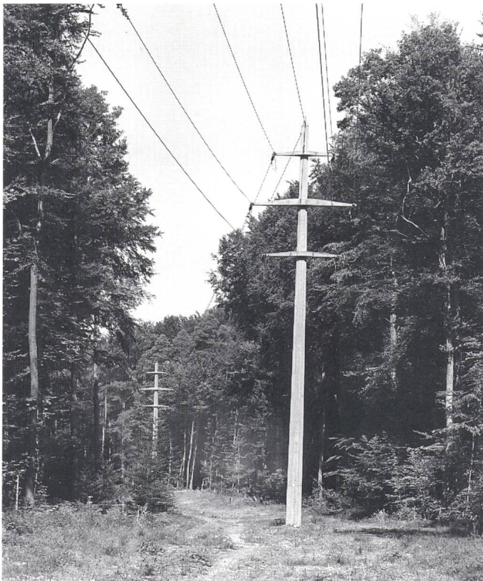
Bild 6 Verwendung eines Waldweges zur Leitungsführung
