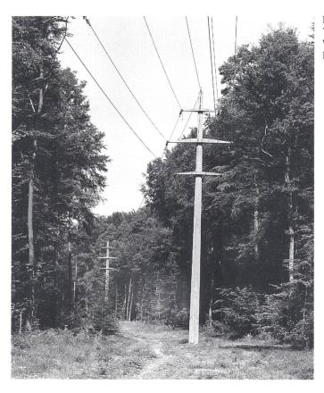
Bild 6 Verwendung eines Waldwėges zur Leitungsführung
