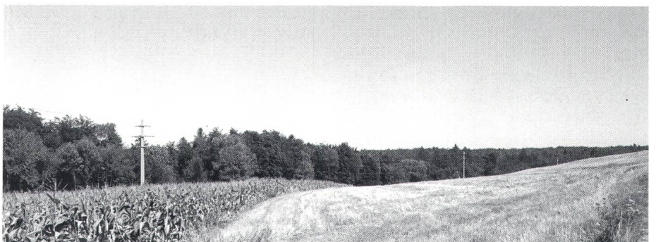
Bild 5 Mast mit Wald im Hintergrund
