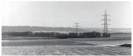
Bild 3 380-kV-Leitung mit 2 bzw. 3 Ebenen
