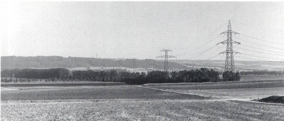
Bild 3 380-kV-Leitung mit 2 bzw. 3 Ebenen
