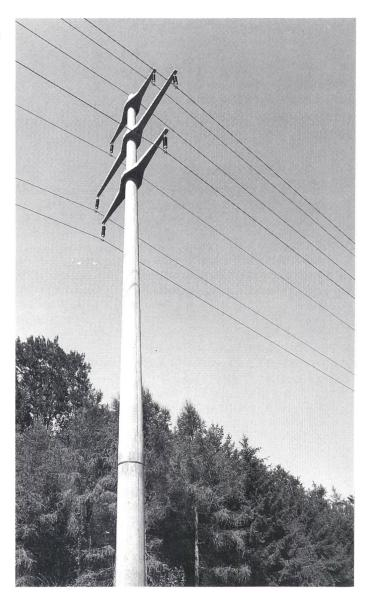
zu gross wäre. Die zylindrisch/konischen Pfeiler haben den grossen Vorteil, dass sie weniger als einen Quadratmeter Land beanspruchen. Zusätzlich müssten die Betonfundamente der Gittermasten sichtbar sein, damit die metallischen Teile einerseits gegen die vom Boden herrührende Korrosion und andererseits gegen eventuelle Beschädigung durch landwirtschaftliche Maschinen geschützt werden können.
