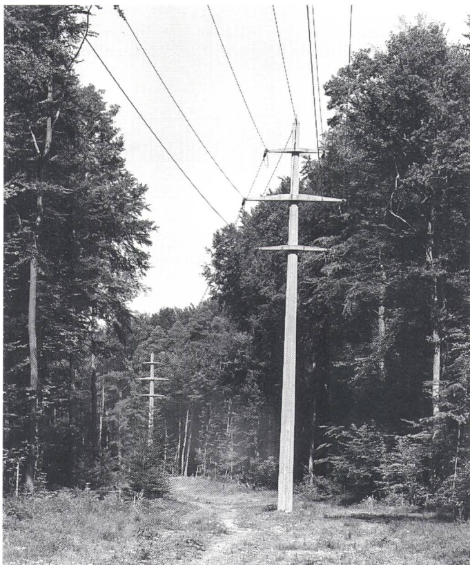
Bild 6 Verwendung eines Waldweges zur Leitungsführung
