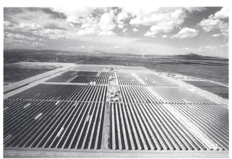
Bild 3 Parabolrinnen-Solarkraftwerk der Firma Luz in Kalifornien
