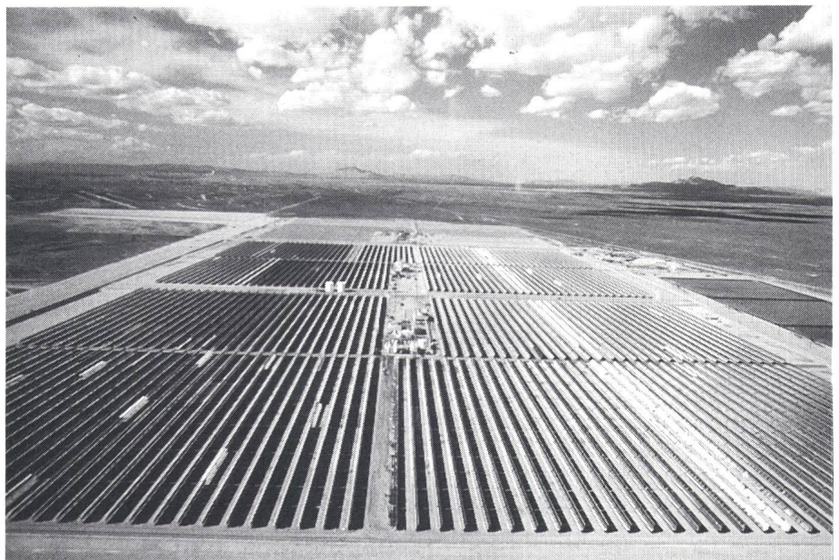
Bild 3 Parabolrinnen-Solarkraftwerk der Firma Luz in Kalifornien
