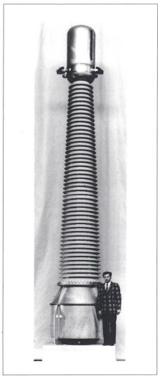
Bild 2 Konventioneller ABB-Stromwandler für 800-kV-Betriebsspannung
