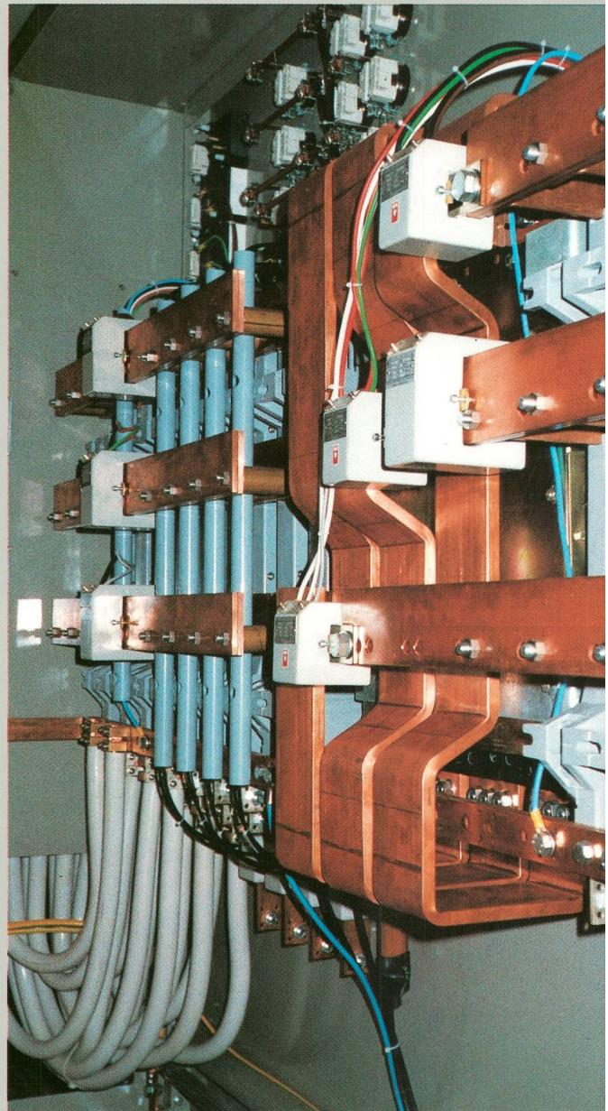
NSV 380/220 Volt in geschlossener Bauweise, Schalttafel bestückt mit den 3-polig schaltbaren, vollisolierten Lasttrennsicherungen sowie einem Leistungsschalter
