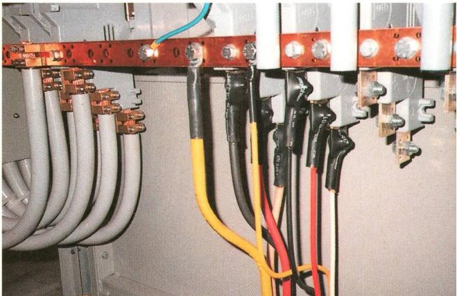
**3 pol. Lasttrenn-Sicherungen, vollisoliert
