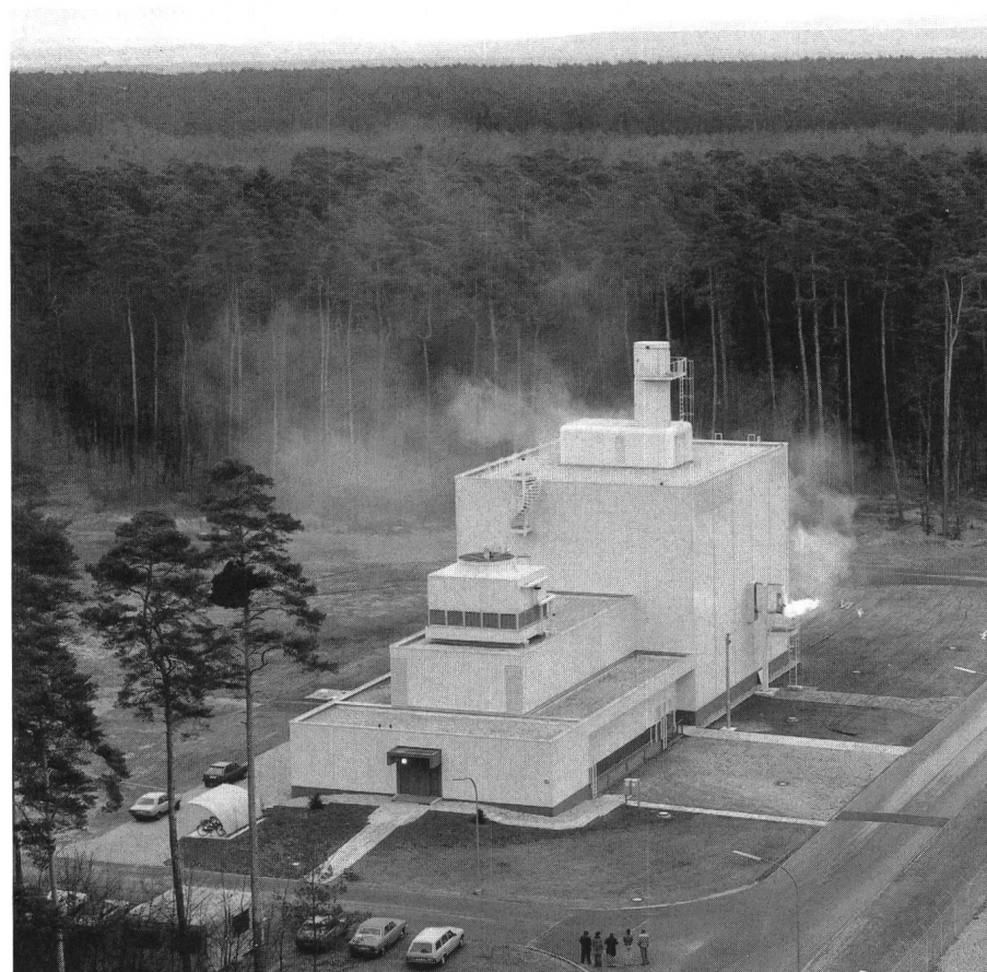
Bild 2 Im Kernforschungszentrum Karlsruhe (KfK) wird in internationaler Zusammenarbeit die Reaktion zwischen Kernschmelze und Beton untersucht, um realistische Messwerte für Quellterm-Studien zu gewinnen. Diese Reaktion würde stattfinden, nachdem die Schmelze durch den Reaktordruckbehälter gedrungen und auf das Betonfundament des Reaktorgebäudes gefallen wäre. Für die Versuche wurde auf dem KfK-Gelände ein eigenes Gebäude errichtet, die Beton-Test-Anlage BETA (Betontiegel-Schmelz-Anlage).
