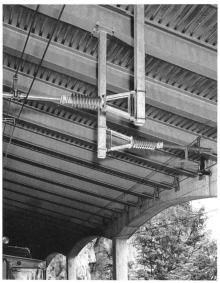
Bild 3 15-kV-Bahnisolator der Sefag AG im Lötschberg-Tunnel (BLS)
