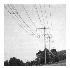
Bild 5 50/20-kV-Kompaktleitung der CKW mit silikonbeschirmten Phasenabstandhalter
