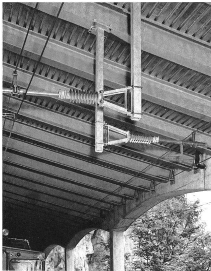
Bild 3 15-kV-Bahnisolator der Sefag AG im Lötschberg-Tunnel (BLS)
