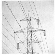
Bild 2 400-kV-Hochspannungsfreileitungsmast mit Silikonisolatoren (NOK)
