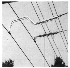
Bild 4 15-kV-Silcosil-Bahnisolatoren (SBB)
