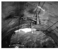
15kV-Silcosil-Verbundisolatoren der im Lötschbergtunnel der erlauben einen störungsfreien Bahnbetrieb über Jahre - auch bei extremer Verschmutzung – ohne Wartungsaufwand.
