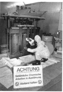
Bild 3 Die Dekontamination eines PCBverseuchten Transformators erfordert ein äusserst sorgfältiges Vorgehen.
