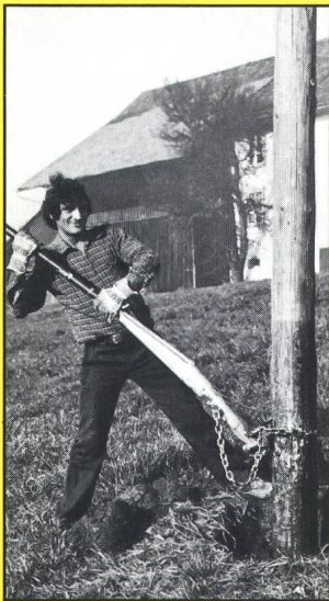
Nachimprägnierung von Holzmasten
