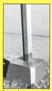
Betonsschutz an Mastsockeln
