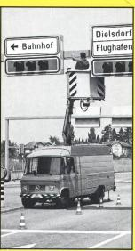
Korrosionsschutz an Signalanlagen
