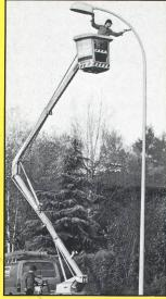
Korrosionsschutz an Stahlkandelabern
