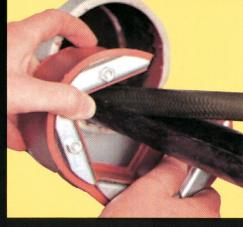
Durch einen sauberen Schnitt des Stopfrahmens kann die Dichtung auch bei bereits verlegten Kabeln montiert werden.
