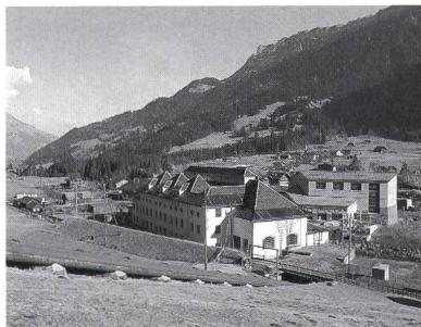
Im Februar haben die BKW ihr 1908–1911 erbautes Kraftwerk Kandergrund stillgelegt. Anfang 1991 wird die neben dem alten Maschinenhaus errichtete neue Anlage in Betrieb genommen. Mit dem neuen Werk lässt sich die Produktion um rund einen Viertel auf 92 Mio. kWh erhöhen. Auf dem Bild ist die neue Zentrale mit zwei vertikal-achsigen Pelonturbinen zu je 9,5 MW Leistung hinter dem alten Kraftwerk zu sehen.
