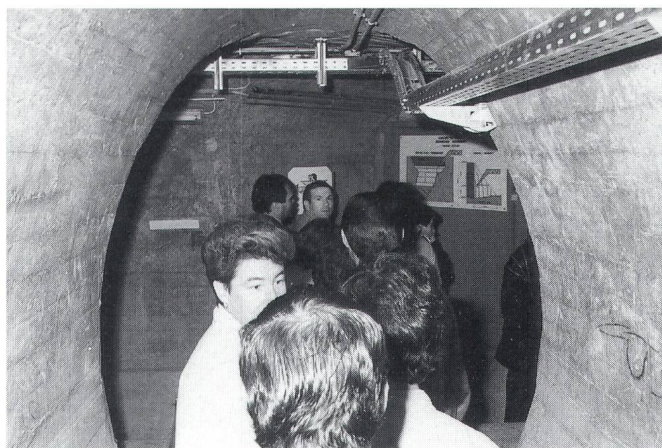
Auf einem Rundgang von 1 km Länge wird den Besuchern ein Einblick in das Innenleben der höchsten Beton-Gewichtsstaumauer der Welt vermittelt.
