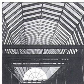
Hochbaukonstruktion (Unternehmensbereich Stahlbau)
