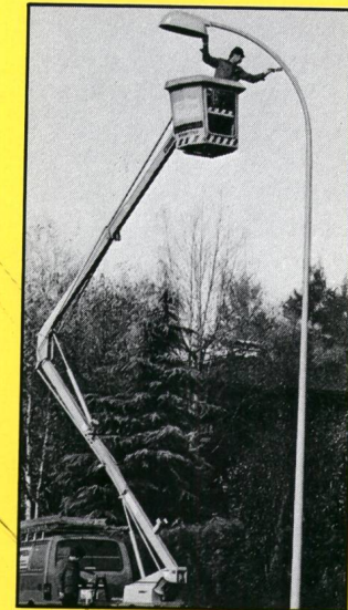
Korrosionsschutz an Stahlkandelabern
