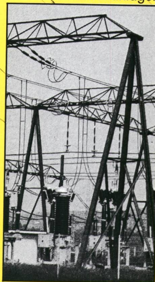
Korrosionsschutz an Schaltanlagen
