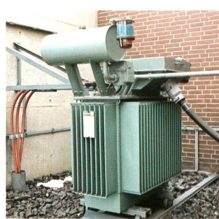
Das ist Verteiltrafo-Standard. Weltweit zehntausendfach bewährte Öltrados in verschiedenen Ausführungs- und Anschlussvarianten. Leistungsbereich 50 bis 2500 kVA:
