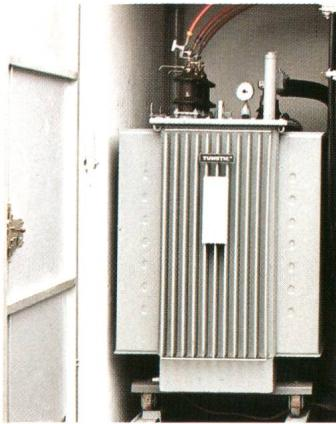
Bei Platzmangel, schwer zugänglichen Standorten und erhöhten Anforderungen an die Wartungsfreiheit ersetzt ein hermetisch geschlossener, elastischer Faltwellenkessel das Expansionsgefäß:
