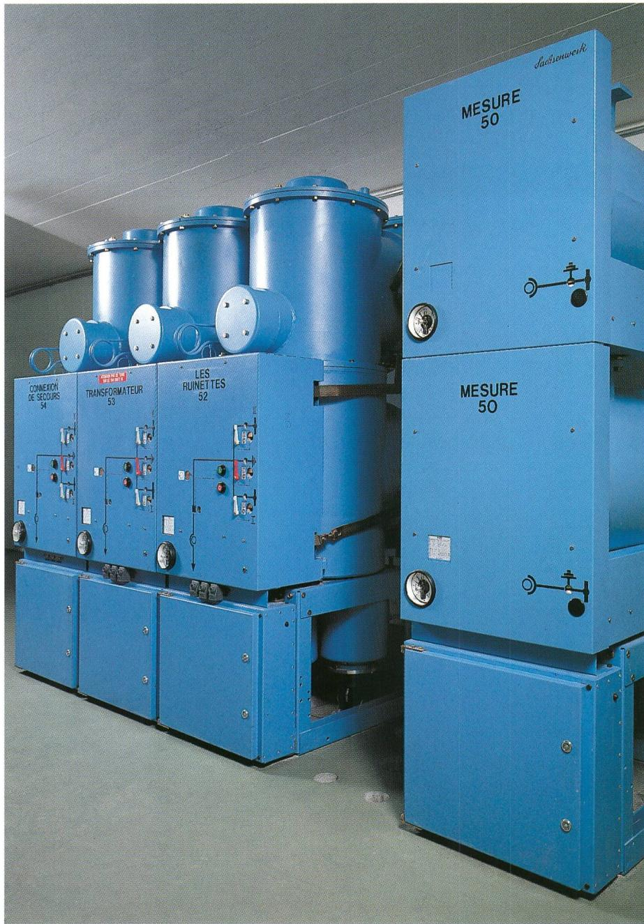
Grâce à son encombrement réduit, l'installation WI-duplex de Verbier a pu être montée dans l'ancienne station SiB, sans agrandissement du bâtiment
