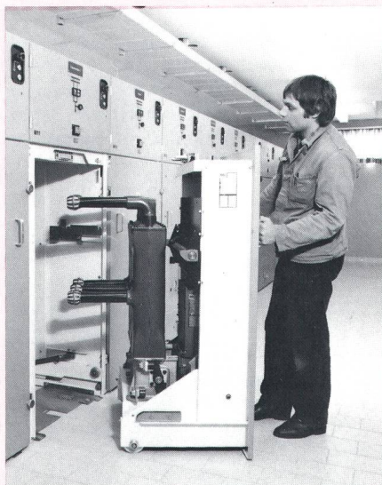
Gasisolierter Schalter in Kompaktausführung
