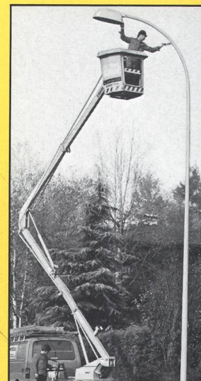
Korrosionsschutz an Stahlkandelabern
