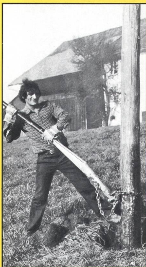
Nachimprägnierung von Holzmasten
