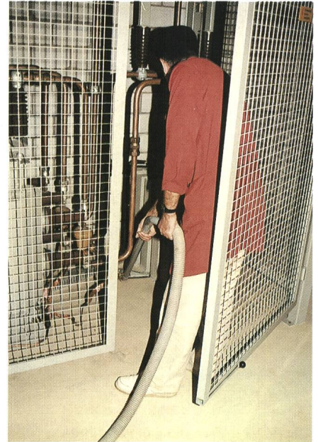
Figur 5 Putzgeräte nie in elektrischen Betriebsräumen unbeaufsichtigt arbeiten lassen
