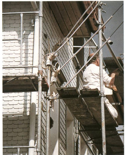
Figur 8 Malerlehrling schlüpfte durch provisorisch isolierte Frontanschlussdrähte
