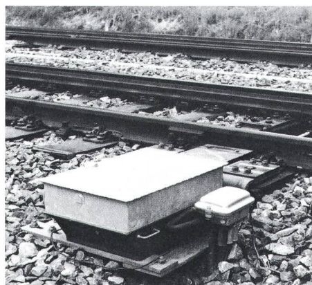
Figur 8 Integra-Weichenantrieb
