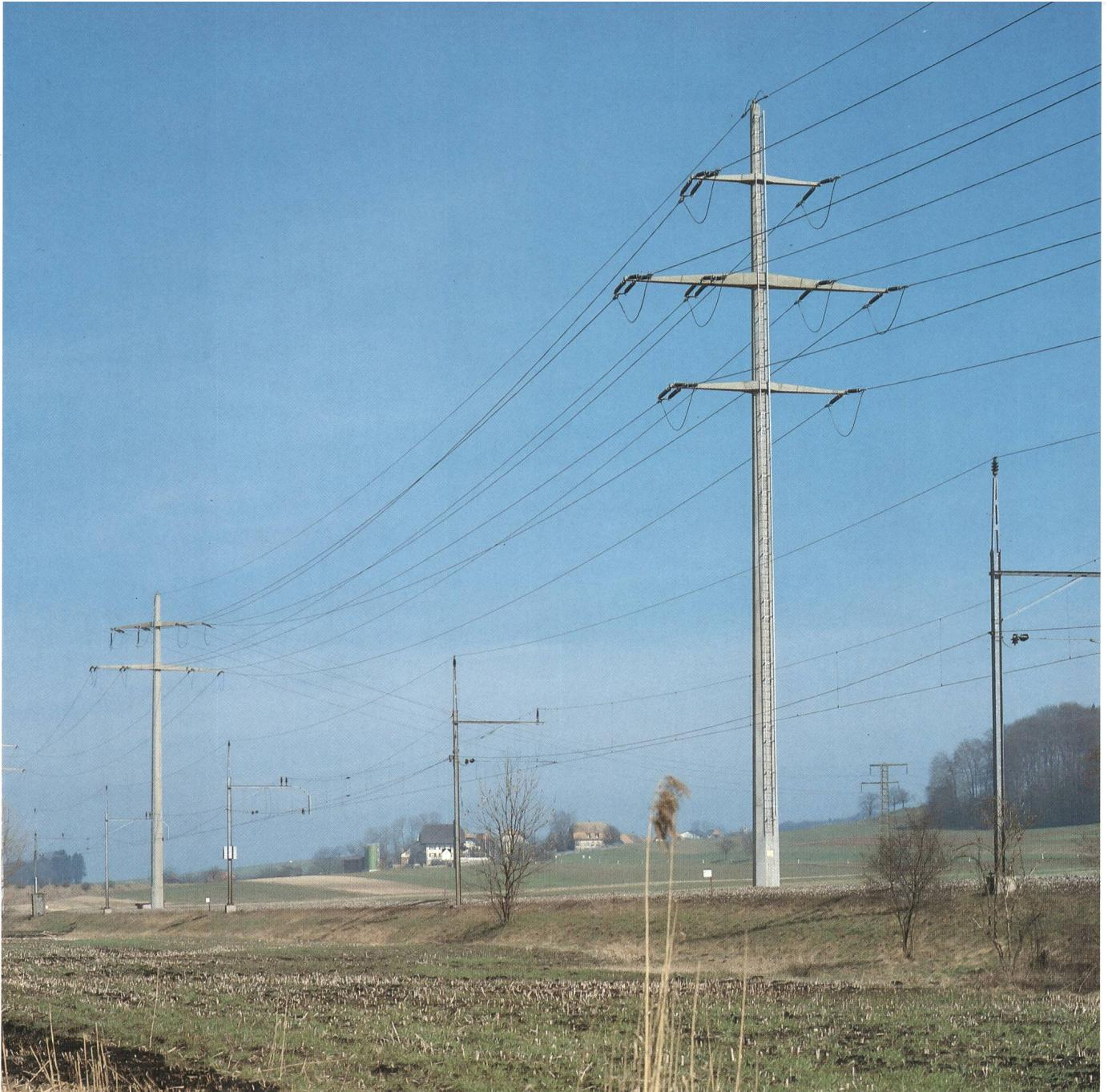
L'illustration ci-dessus présente un des nombreux mâts Gram en béton armé et précontraint livrés dans le cadre de la réalisation de l'important projet de la ligne de transport de 132 kV des Chemins de fer fédéraux suisses qui relie **Kerzers à Biel**.
