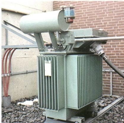
Das ist Verteiltrafo-Standard. Weltweit zehntausendfach bewährte Öltralos in verschiedenen Ausführungs- und Anschlussvarianten. Leistungsbereich 50 bis 2500 kVA:
