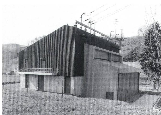
Die CKW-Unterstation Küssnacht wird ab der Netzeitstelle Rathausen ferngesteuert und überwacht, so dass nur noch alle zwei Wochen ein Kontrollgang durchgeführt werden muss.
