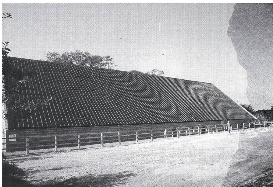
Figur 3 Ein 50-kW-Generator auf Fota Island, Irland. Er ist als «Kaltdach» direkt auf die Dachlattung aufgesetzt. Das Gebäude gehört zu einer Milchfarm mit 250 Kühen der Universität Cork und versorgt diese autark über einen Bleiakkumulator-Speicher mit elektrischer Energie. Photo: AEG-Olympia, Hamburg
