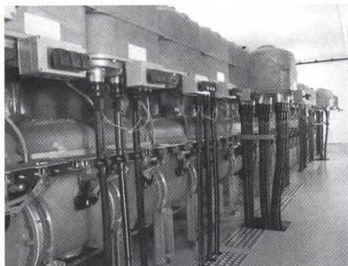
Innenkonus-Kabelstecker der Sefag AG Mal- ters, angeschlossen an metallgekapelte SF 6 - isolierte 24-kV-Mittelspannungsschaltanlage.
