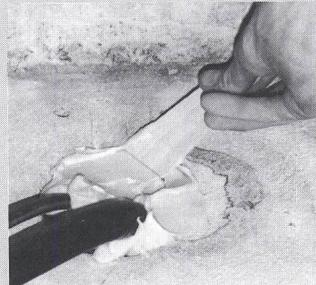
fen wie PVC, PE, XLPE, EPR, Eisen, Kupfer, Blei und Beton, auch auf nassem und staubigem Grund. Sie ist luft-, gas- und wasserdicht bis 1,5 bar. Weitere Vorzüge sind ihre Dauerelastizität und Wärmebeständigkeit; zudem ist sie selbstlöschend, halogenfrei sowie entfernbare für eventuellen späteren Kabelnachzug.
