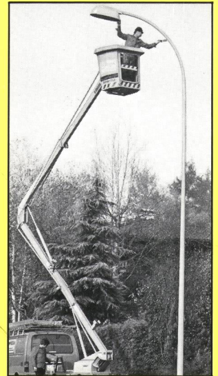
Korrosionsschutz an Stahlkandelabern
