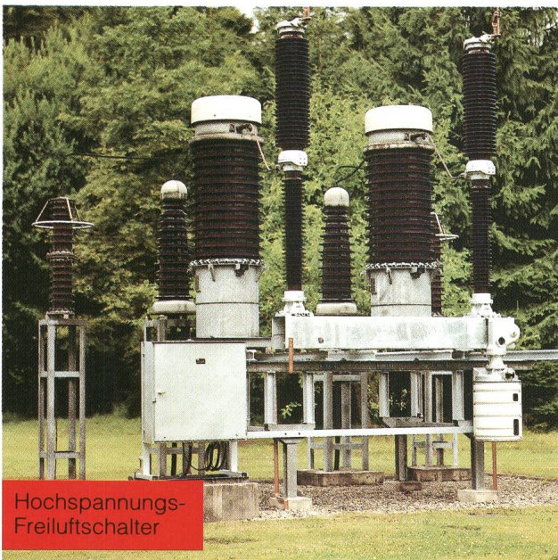
SF 6 -gasisolierte Schaltanlage
