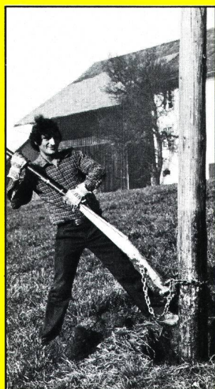
Nachimprägnierung von Holzmasten
