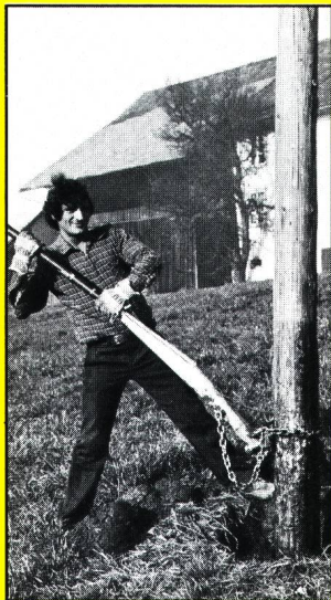
Nachimprägnierung von Holzmasten
