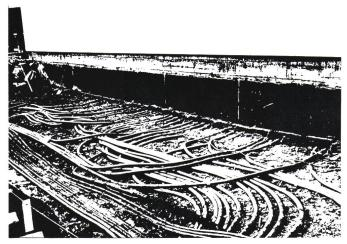
Figur 2 Kabel im offenen Graben, Schalthaus Altenessener Strasse
