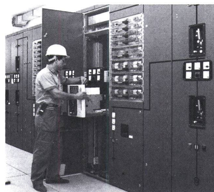
Figur 2 Ausfahren eines Leistungsschalters an einer wartungsfreundlichen Niederspannungs-Schaltanlage
