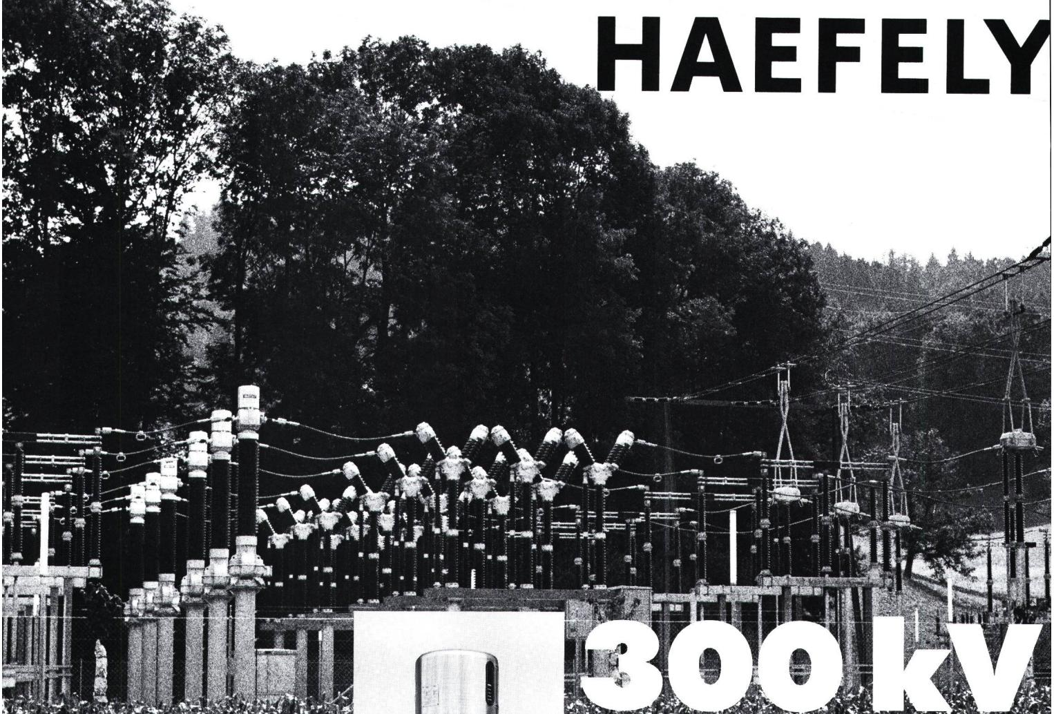
Haefely hat speziell für die Schweizer Netzverhältnisse Strom-, Spannungswandler und Messgruppen mit einer dauernd zulässigen Betriebsspannung von 300 kV entwickelt.
