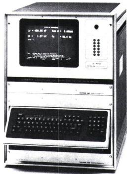
wie die Umschaltungen der einzelnen Mess- und Anzeigebereiche erfolgen automatisch. Das Messsystem wird mit einer Vielzahl von zusätzlichen Optionen angeboten.
