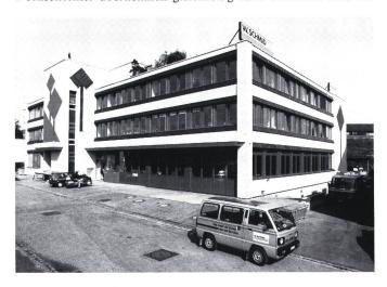
Die 6-kW-Solarzellenanlage ist vollständig in die Fassade integriert und bei oberflächlichem Betrachten kaum von der normalen Fassade zu unterscheiden.
