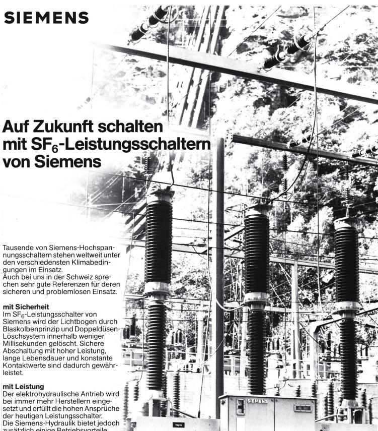
zusätzlich einige Betriebsvorteile bezüglich Dämpfung, Mechanik und Druckkontrolle.
