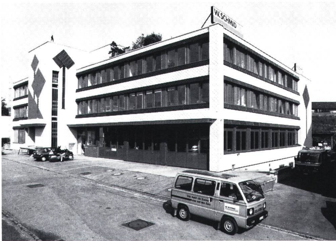
Die 6-kW-Solarzellenanlage ist vollständig in die Fassade integriert und bei oberflächlichem Betrachten kaum von der normalen Fassade zu unterscheiden.
