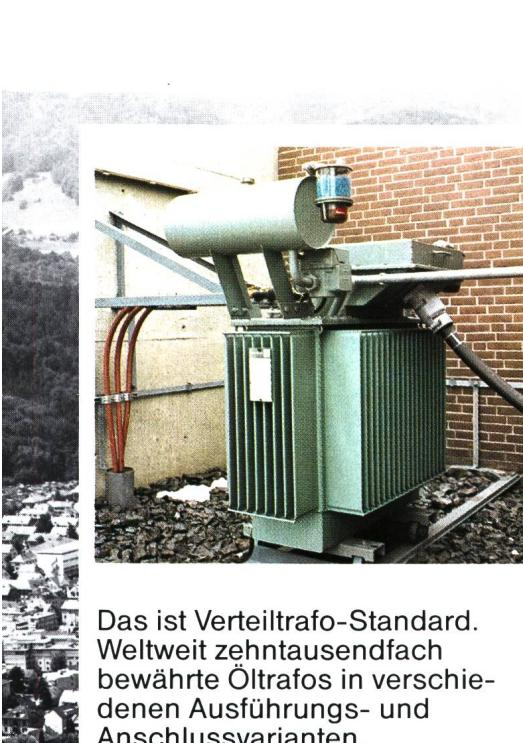
Das ist Verteiltrafo-Standard. Weltweit zehntausendfach bewährte Ölfasos in verschiedenen Ausführungs- und Anschlussvarianten. Leistungsbereich 50 bis 2500 kVA:
