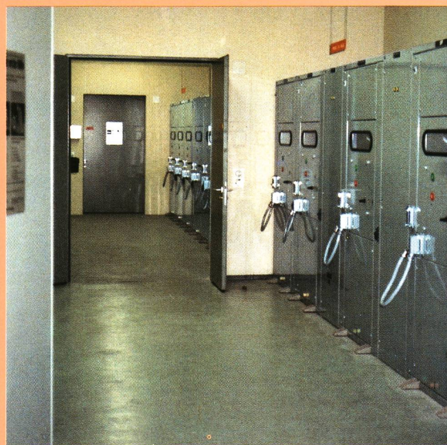
Fig. gauche: Armoire avec 3 contacteurs à vide 6kV en couplage Dahlander, pour la ventilation
